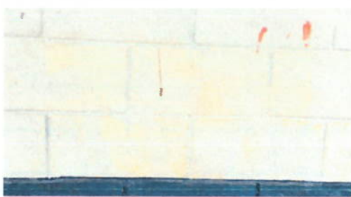
Foto 5: PINTURA EN MUROS INTERIOR Y EXTERIOR
